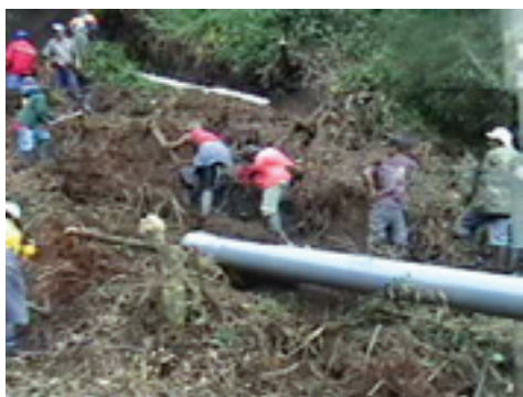
Figura 4.7. Reparación de daños en la captación de Curitroje año 2005
