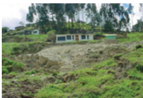
Figura 4.5. Deslizamientos causados por aguas freáticas (Amable María)
