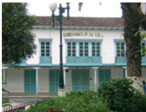
Figura 3.8. Edificio de la Gobernación
